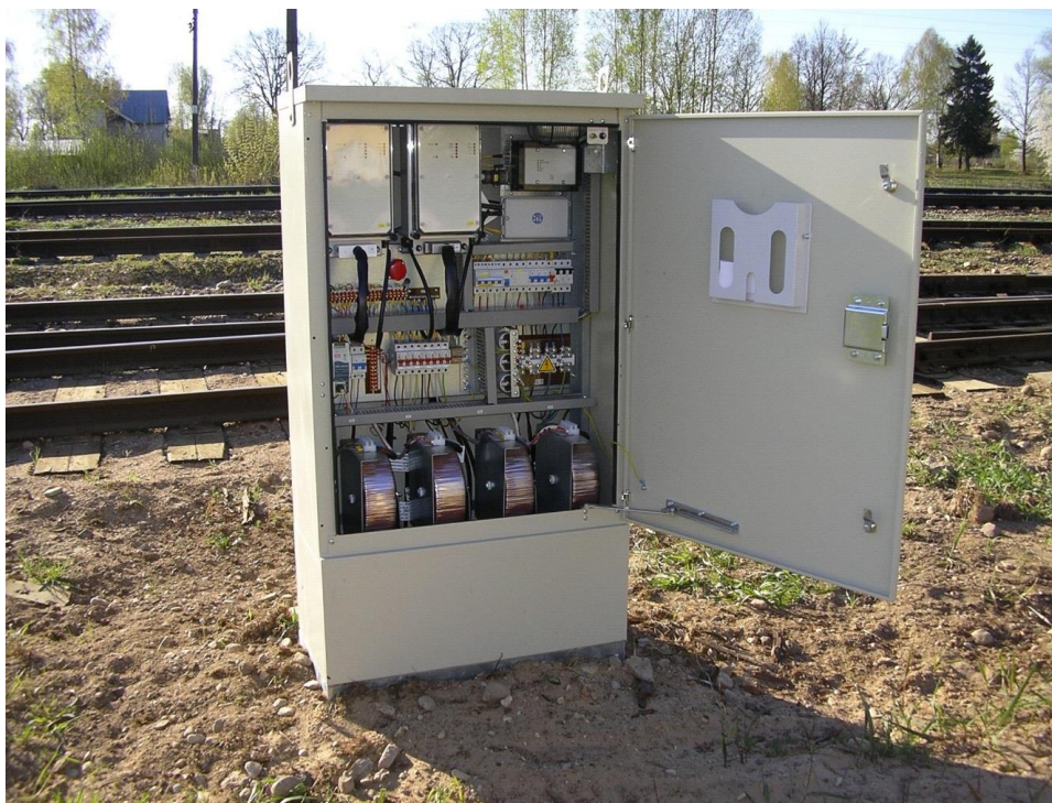
Рис. 2. Наполнение релейного шкафа
